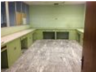
FOTOS NAVE ASTIGI 002.jpg
