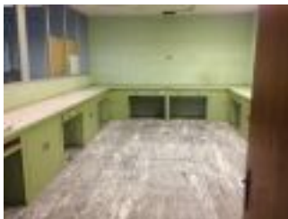
FOTOS NAVE ASTIGI 002.jpg
