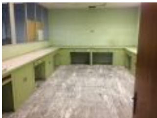
FOTOS NAVE ASTIGI 002.jpg
